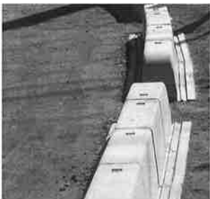
防草型ブロックの試験施工
