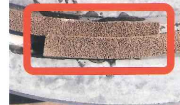
④ 接合部にスポンジを敷き並べ端部は5cm以上重ね合わせる
