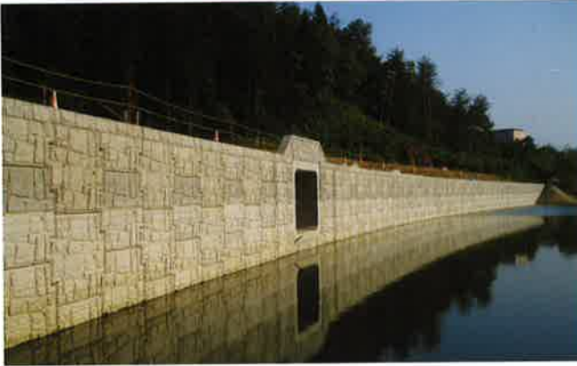
秋田県 / 明永 2 期地区ふるさと農道 総壁面積 1,531m 2 壁高 10.5m
