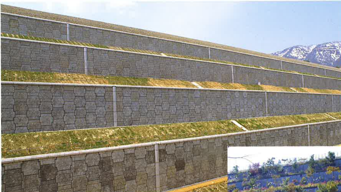
富山県 / 中部北陸連系所(中部電力) 総壁面積 7,697m 2 合計壁高 5段積み 36.75m(国内最高)
