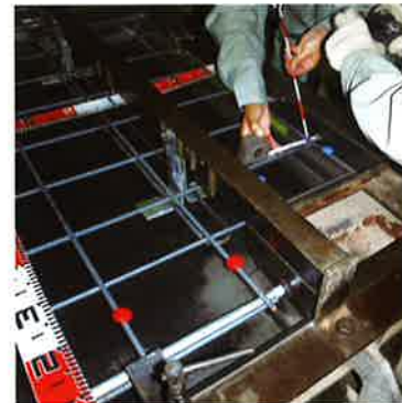
配筋検査状況
