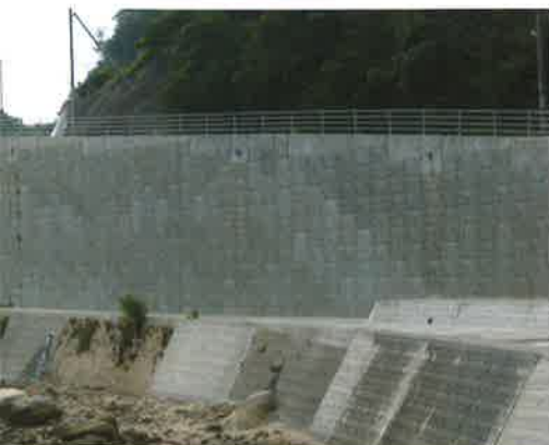
壁面積 680m 2 壁高 11.25m
