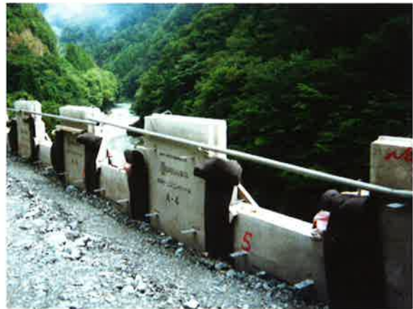
転落防止(施工時)
