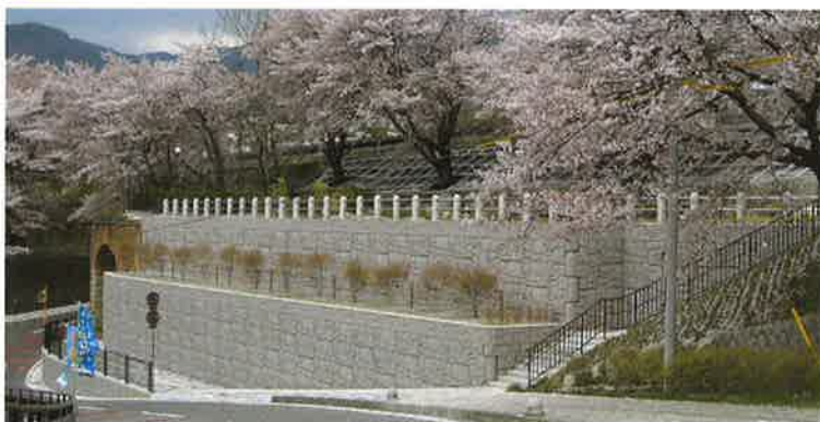
御影調による吹付け
