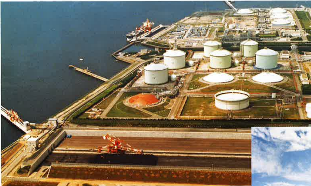
埋立地上に構築された石炭備蓄ヤード
