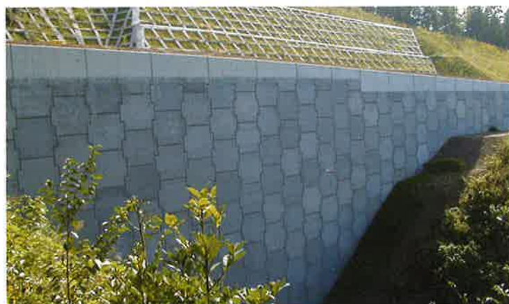
島根県 / 江津道路(上條西地区) 壁面積 669m 2 壁高 14.25m
