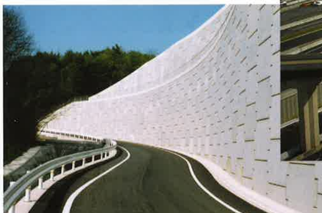
山口県 / 山口宇部線 総壁面積 1,587m 2 合計壁高 18.0m
