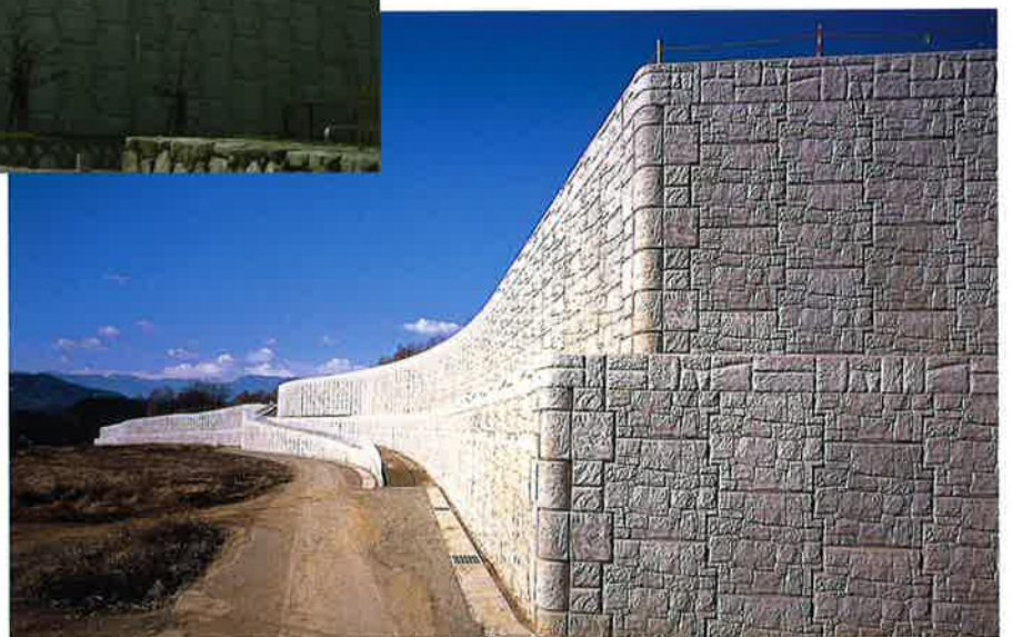
山梨県 / 米倉山ニュータウン造成 総壁面積 7,782m 2
