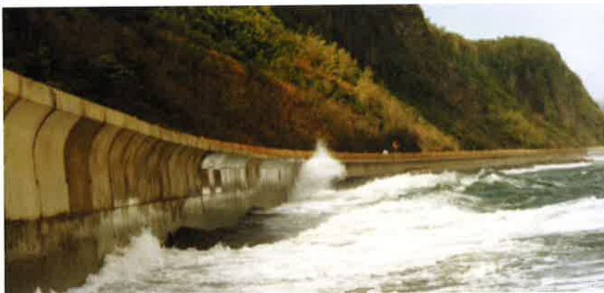
カナダ / Carleton Seawall 総壁面積 55,000m 2 延長 13.1km
