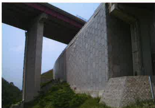
EPSと併用した複合橋台の事例
