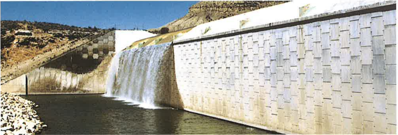
〈放出量 1,850m 3 /s を有するダム堤体〉
