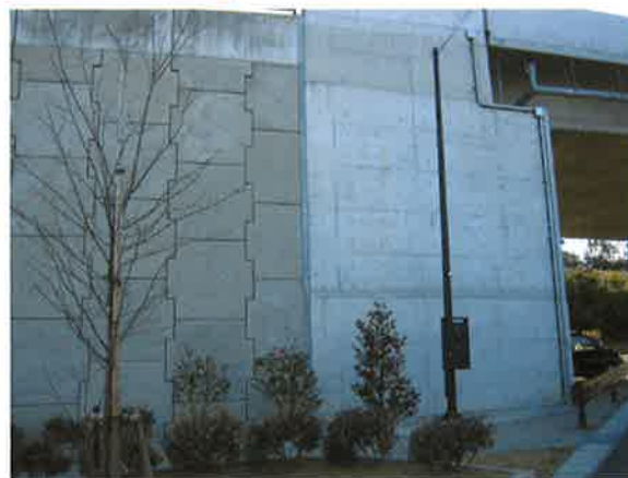
橋台との取合い
