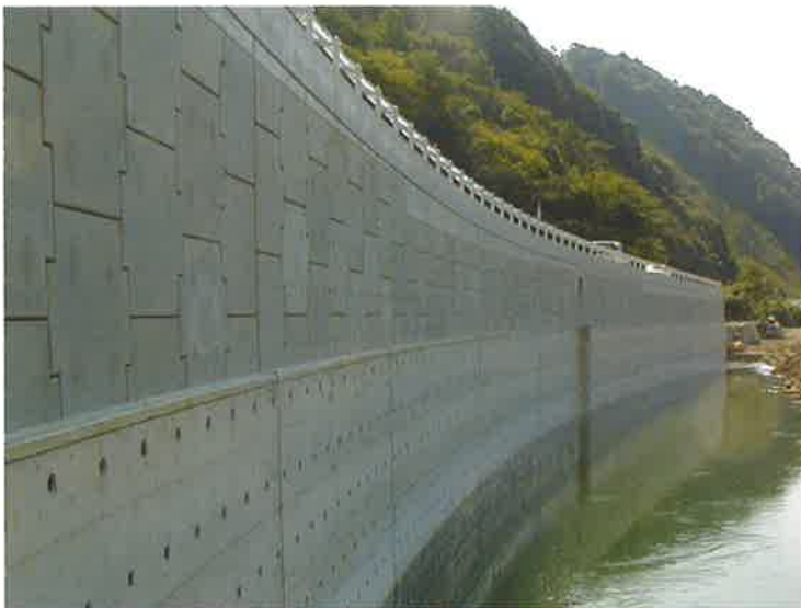
宮崎県 / 国道 388号 総壁面積 2,480m 2 壁高 11.25m
