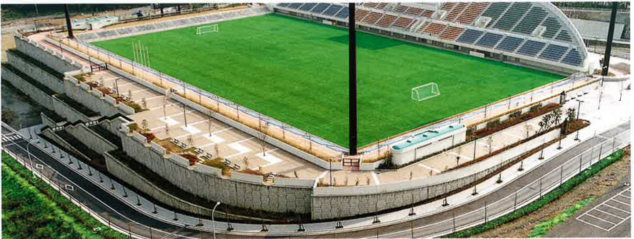
静岡県 / 日本平運動公園造成工事(清水エスパルス本拠地・3段積) 総壁面積 4,699m 2 合計壁高 15.75m
