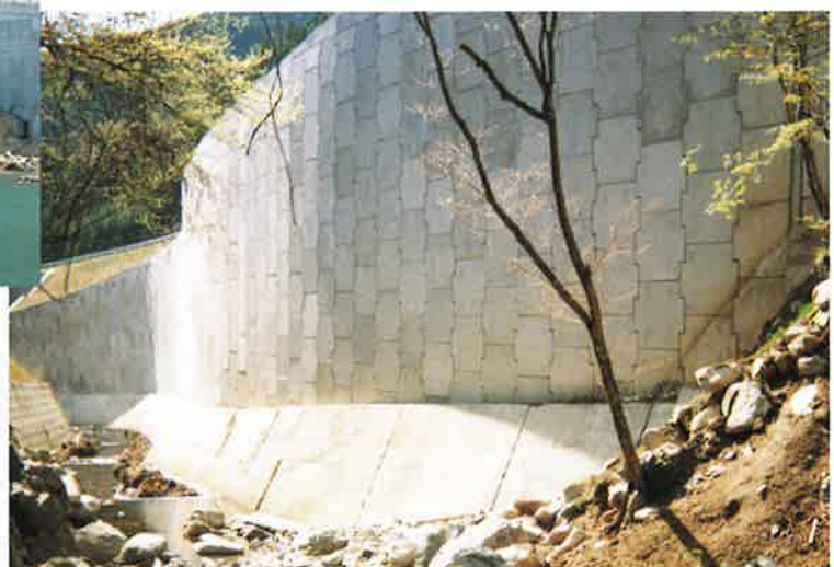
コンクリート架台を護岸として併用した例
