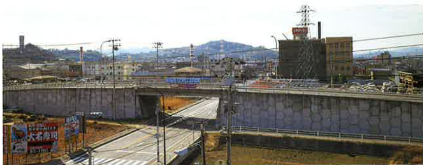
岡山県 / 玉島臨港工事 壁面積 1,452m 2 壁高 6.0m
