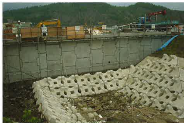
鹿児島県 / 牛根高架橋 壁面積 129m 2 壁高 4.5m
