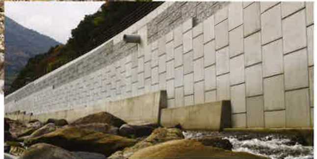
国土交通省中国地方整備局 国道9号線津和野川左岸工事
