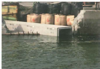
写真-3 山口県大島郡周防大島町(伊保田港) ボックスカルバート 1200×1200mm
