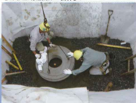
⑤浸透用直壁の据付け
