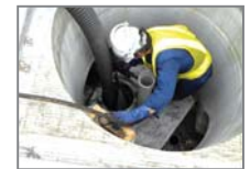
貯留水の抜き取り
