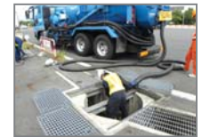
清掃作業の状況
