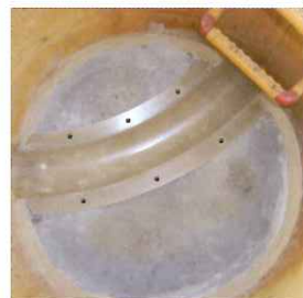
マンホール土間にインバートカバー用アンカーを打ち込む
