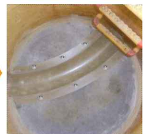
インバートカバーをナット締めにより設置完了
