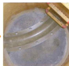
インバートカバーをナット締めにより設置完了
