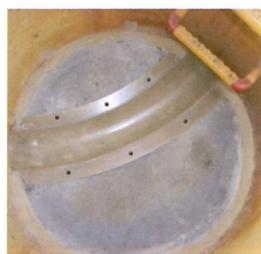
マンホール土間にインバートカバー用アンカーを打ち込む
